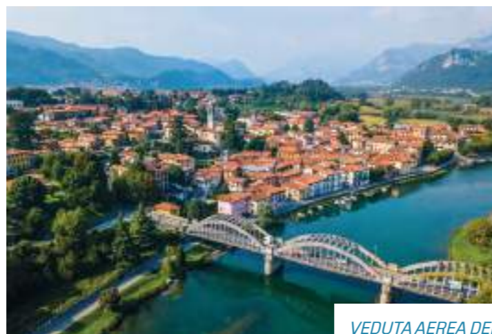
VEDUTA AEREA DEL PONTE AERIAL VIEW OF THE BRIDGE
